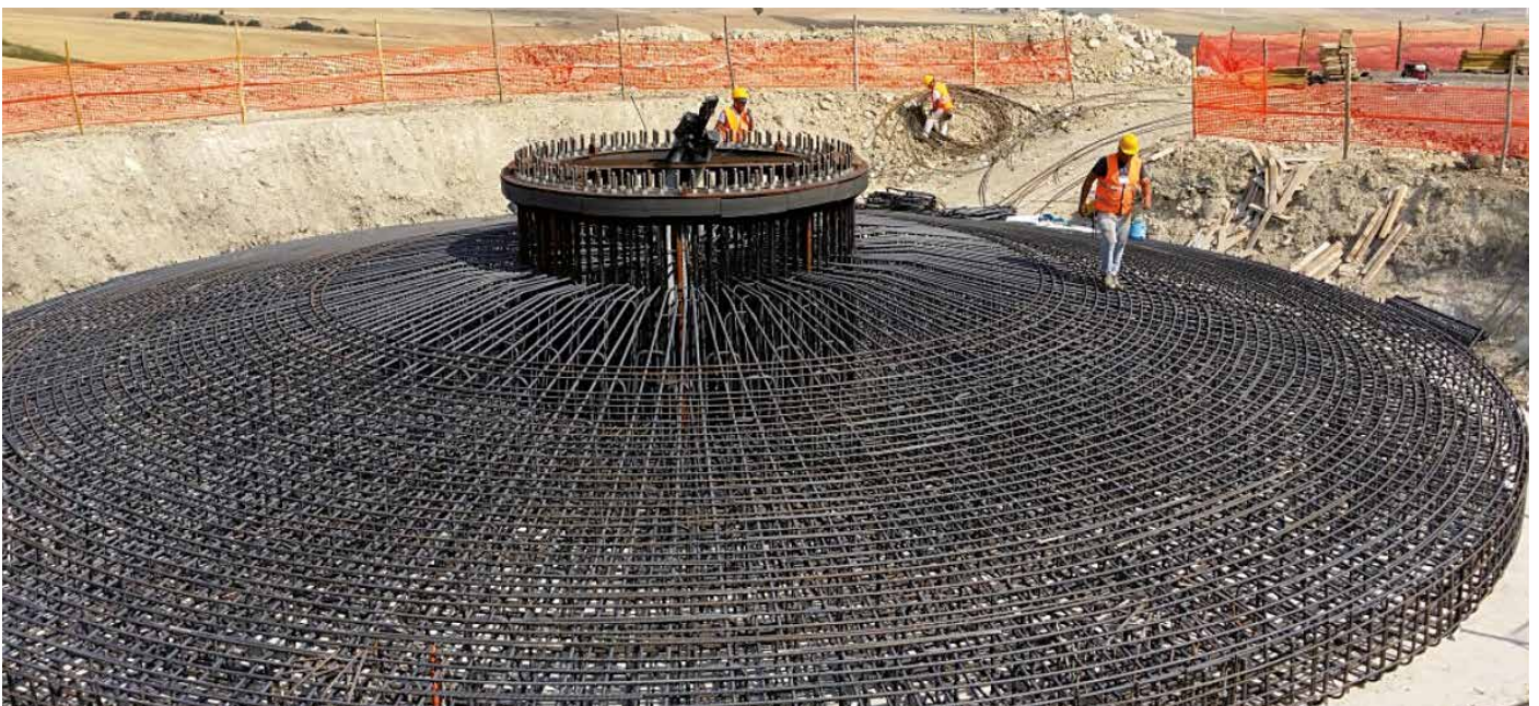
Fundering voor windturbines. De diepteverankering van de funderingsplaat kan gemakkelijk worden uitgevoerd met TRACK PILE™.
