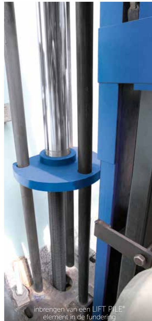
Inbrengen van een LIFT PILE® element
