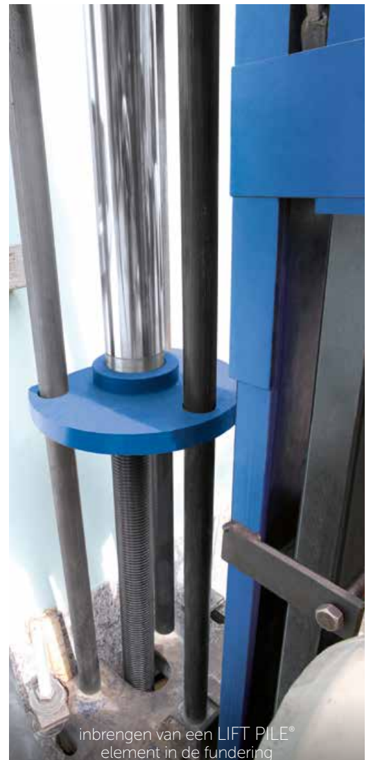
Inbrengen van een LIFT PILE® element
